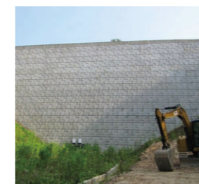
盛土・地盤補強
