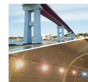
コンクリート構造物 補修・補強
