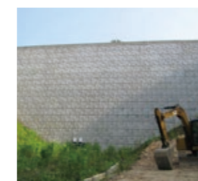
盛土・地盤補強
