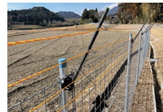
下段に3Dクリップ、中上段にロングクリップを使用した例
